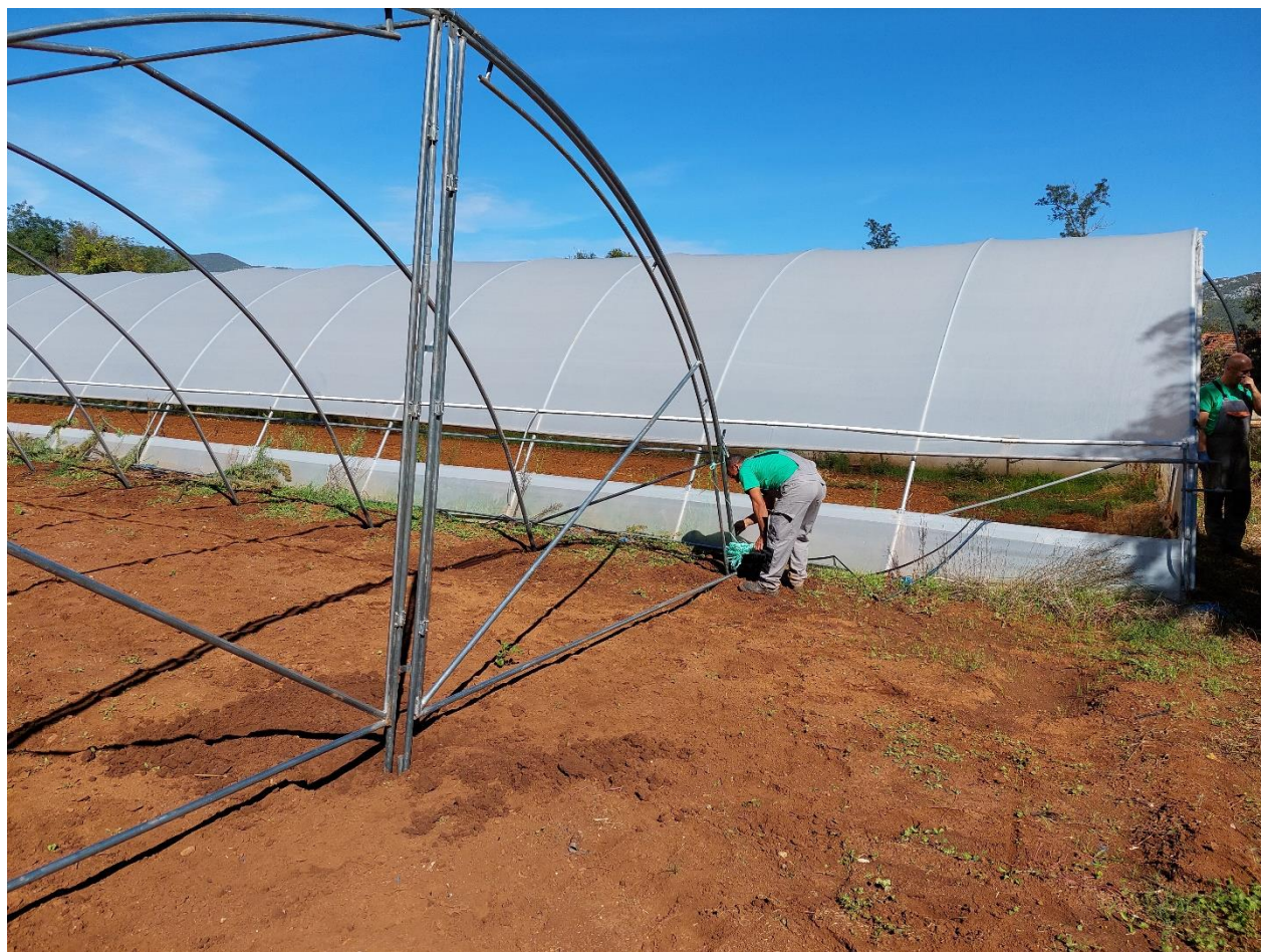
Montiranje plastenika u odmakloj fazi. Foto: PCU/F. Belko
